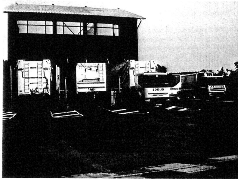
Vue face entrée du site
